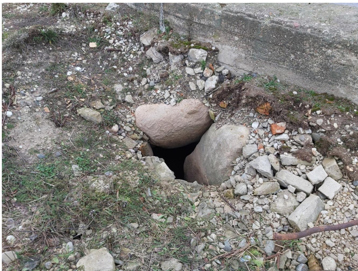
Attēls 4. Grunts (akmeņu) iegruvums gar kordona virsbūvi.
