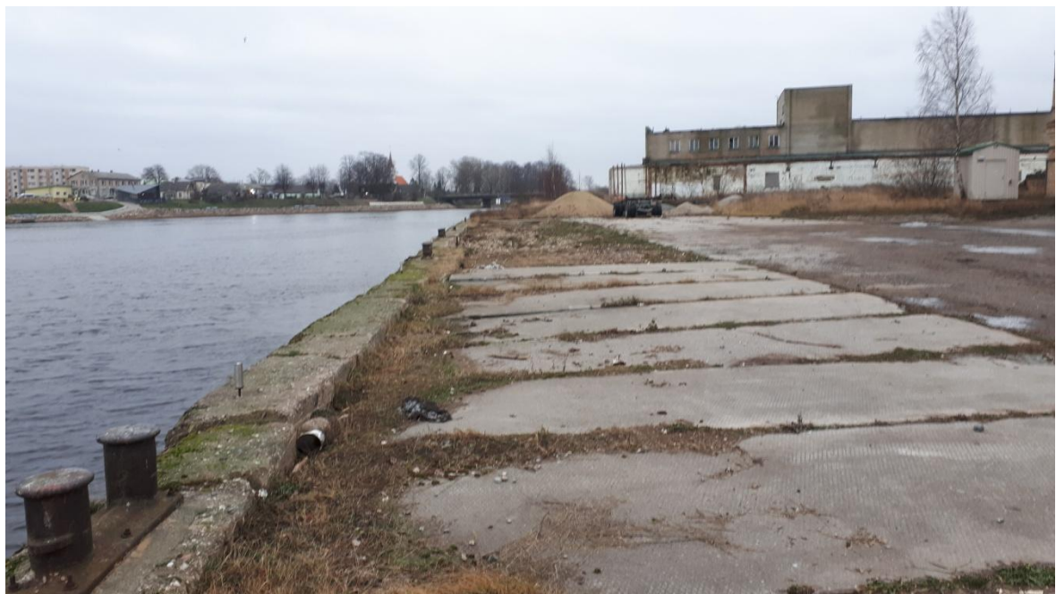
Attēls 2. Skats uz pietātnes dzelzsbetona segumu.
