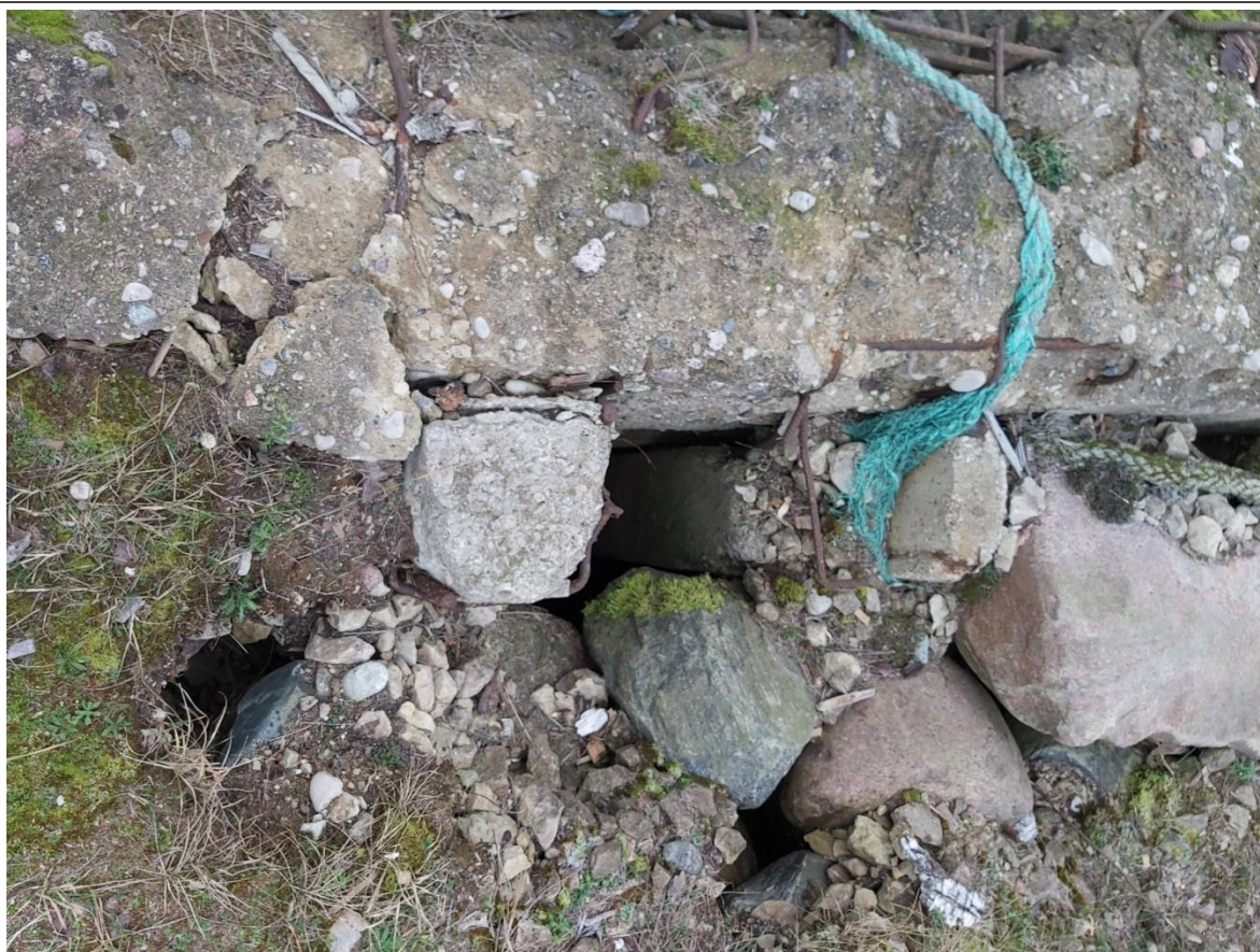
Attēls 3. Grunts (akmeņu) iegruvums gar kordona virsbūvi.
