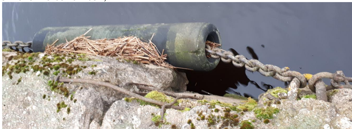
Attēls 6. Skats uz cilindrisko atvairierīci.
