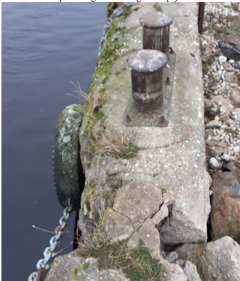
Attēls 7. Skats uz slīdrāgu. Blakus sagrūvusī dzelzsbetona virsbūve.
