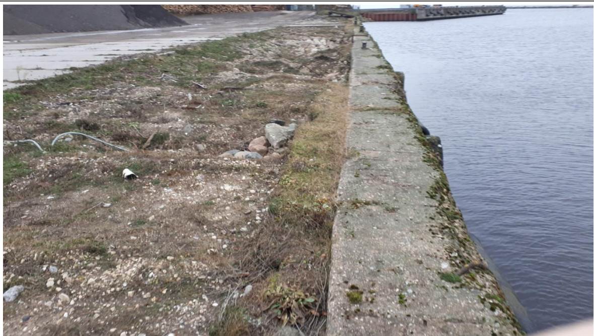
Attēls 1. Skats pietātnes rietumu virzienā. Pietātnes segums demontēts.
